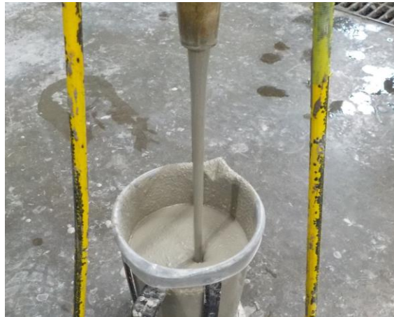
耐酸セラモルタルRの充填状況
