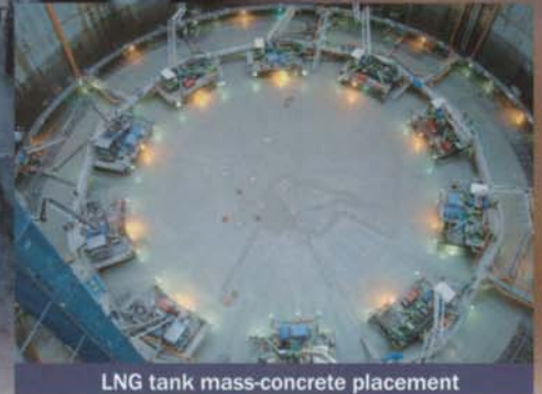
LNG tank mass-concrete placement
