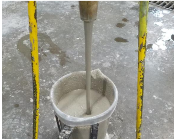
耐酸セラモルタルRの充填状況
