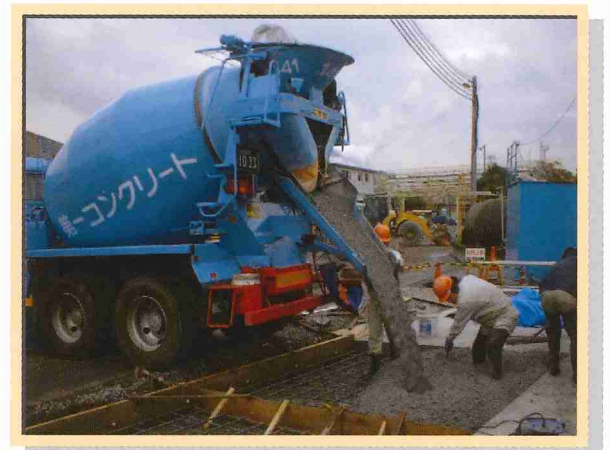
耐酸セラメントを用いたコンクリートの打設状況
