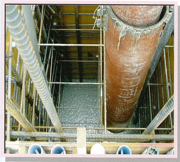
現場打ち高強度コンクリート
