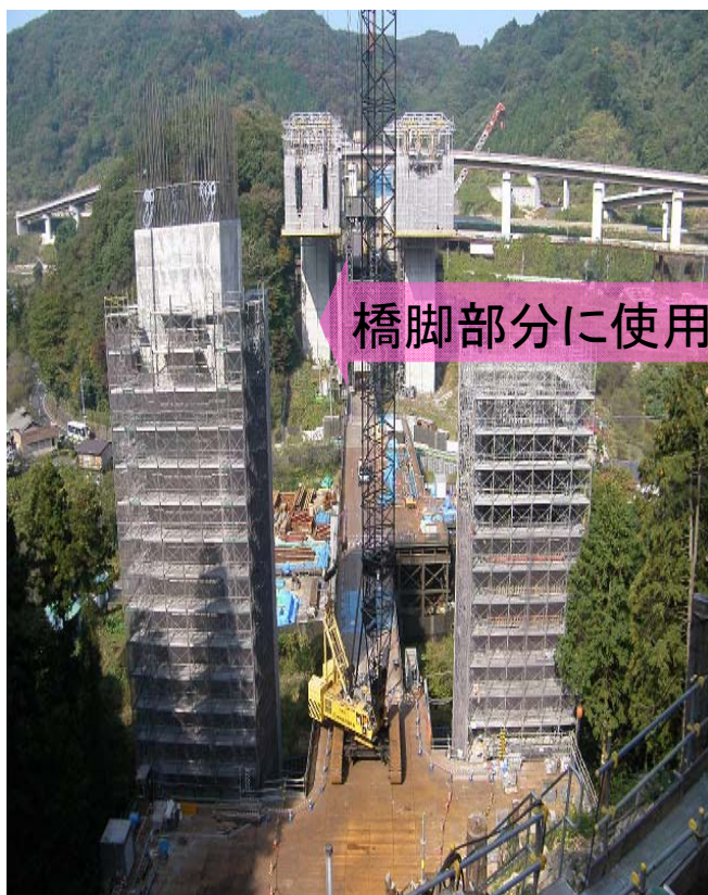
首都圏中央連絡自動車道 裏高尾橋工事
